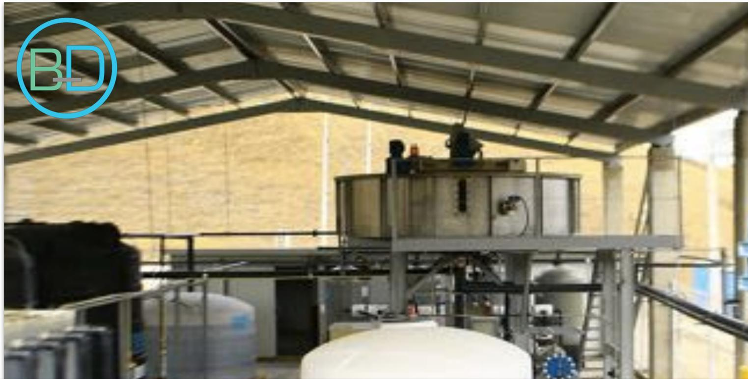
Proyecto especial, PTAR para el tratamiento de los lixiviados del relleno sanitario "Picachos" en Zapopan 6.5 L.P.S.
